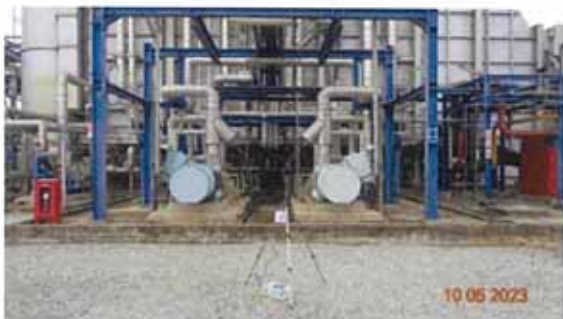
Boiler Feed Pump HRSG#12
